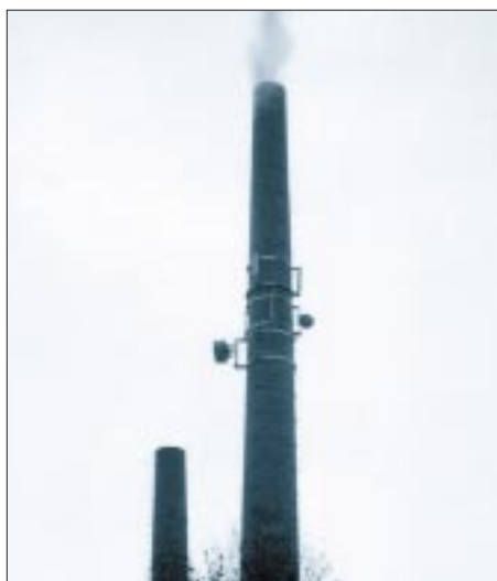
Anbau von Sektorantennen an einen Fabrik-schornstein
